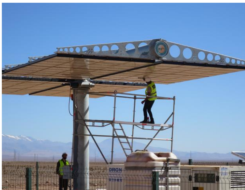
図 20：実際の洗浄作業を現地作業員が行っている写真
