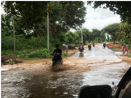
図 3.15: 幹線道路でも自然発生した川が多発
