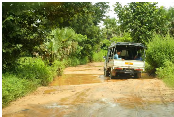
図 3.16: 村への未舗装道路にも水溜りが多発
