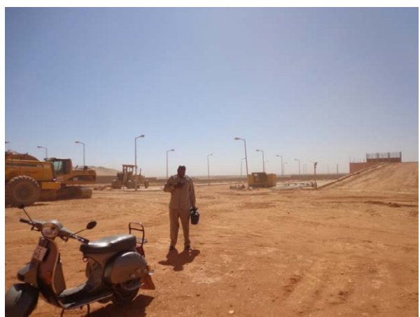
新ウンバダ中継施設建設の様子
