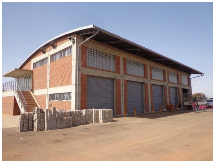
図 1-3 関連無償で建設したセントラルワークショップ（車両整備工場）（2016年4月）
