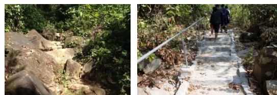
写真5 コミュニティ・インフラストラクチャー支援によって整備された避難路(左：整備前、右整備後)
