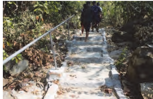
コミュニティ・インフラ支援プロジェクト (避難路整備)
