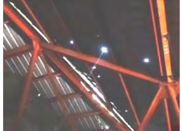
写真 2. テレビ棟屋根
