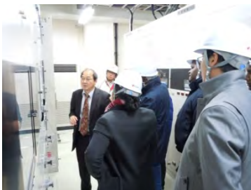
監視制御システム
