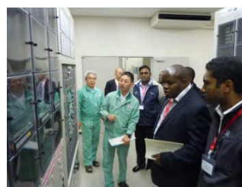
監視制御システム
