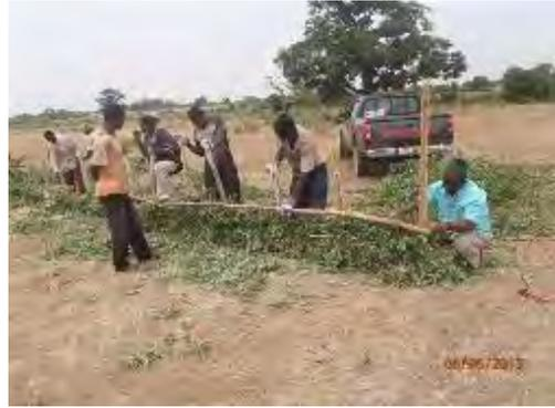
**Figure 1-7 Travaux de mise en place des fascines**
