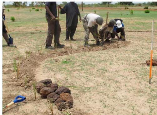
**Figure 1-8 Travaux de mise en place des fascines**
