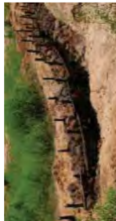
Mise en place de diguette en cadre (pierres)
