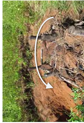
Exemple de décapage de la terre sur le côté de la diguette
