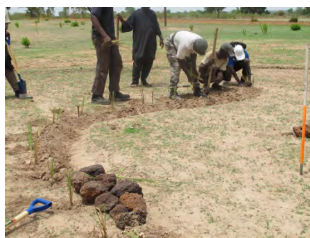
図 1-8 土堰の設置作業
