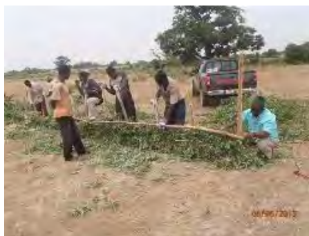
図 1-7 束柴設置作業
