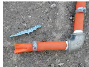
半年で劣化/破損した市販パイプ
