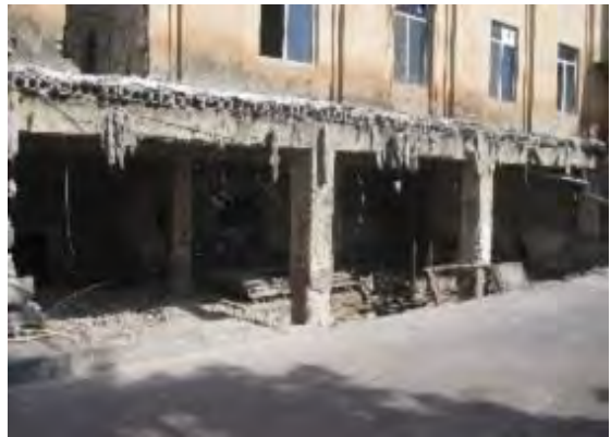
写真-10：改修工事中の化学ラボ及びアーカイブ室となる場所。2016年内に工事完了予定
