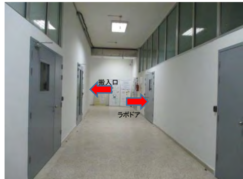
写真-4:要請機材設置予定部屋前通路(地下4階)
