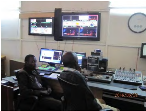
写真-9: 仮設ファイナルコントロールセンター。放送する番組を制御している。
