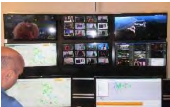
写真-15：国内のデジタル放送及び衛星放送を監視するテレビ・ラジオ放送ネットワークのマスターコントロールルーム
