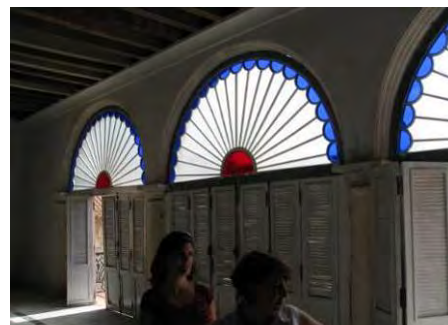
写真-4：2階アーチ型ステンドグラス付窓 内外部の建具修理等は「キ」国側で完了済。
