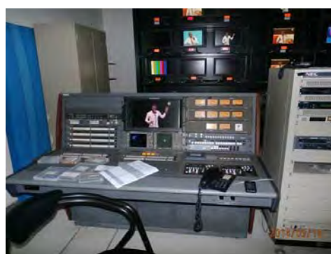
写真-4：第1チャンネル主調整室 番組ソフト送出時の最終調整を行う。
