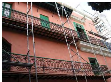
写真-7：裏玄関側 外観 外壁工事は「キ」国側で完了済み。
