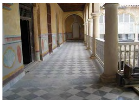
写真-3：2階中庭バルコニー 床の修復等は「キ」国側で完了済。
