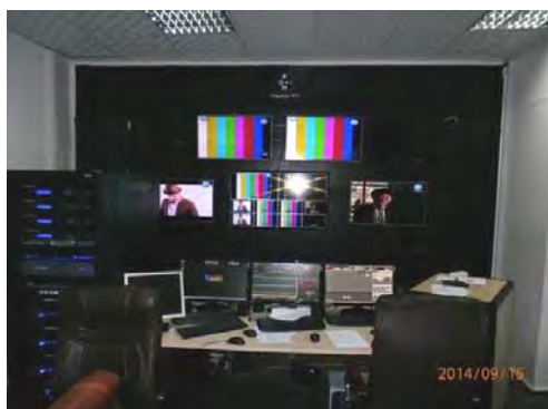
写真-7：地デジ試験用主調整室設備 試験放送中の地上デジタル放送監視機材。
