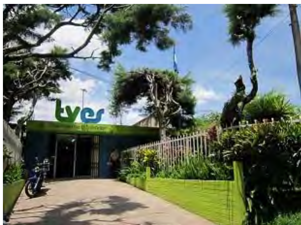
写真 1： 国営教育・文化テレビ局 局舎入口。局舎は教育省ラ・リベルタ県支部に隣接している。
