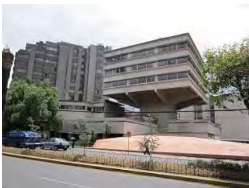
写真-1：CIESPAL 建物全景。2014年9月から2015年末にかけて建物の修復工事中。
