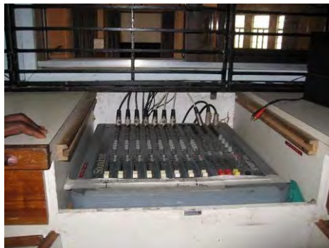
写真-8：講堂用既存 8ch ミキサー チャンネル数が少なく多彩な音源に対応できない。
