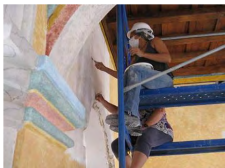
写真-5：内部壁 修復状況 表層の塗装を丁寧に剥し19世紀当時の塗装を復刻している。
