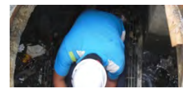
図 3.3.2 マンホールでの清掃作業
