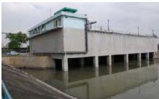
図 5.2.3 調整池の上の土地を活用して建設された処理場
