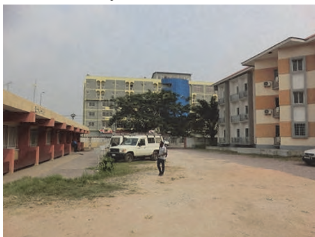
Photo 3 Laboratoire et bâtiment de gestion du programme de lutte contre le SIDA du ministère de la Santé publique situés dans la partie nord du site. La route en terre battue de l'entrée existante au fond jusqu'au-devant est la voie d'approche réservée aux installations du présent Projet.
