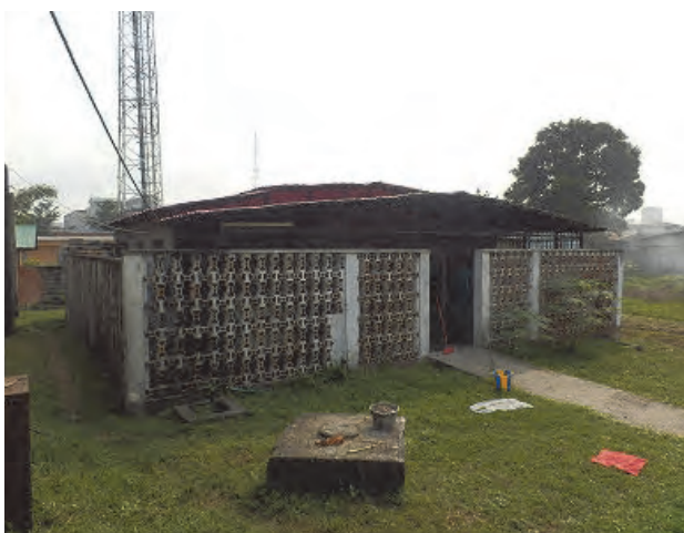
Photo 9 Bâtiment animalier actuel. Les animaux pour les examens et la recherche, dont une partie est vendue, sont élevés dans ce bâtiment. Au fond, les terrains de construction pour le Projet.
