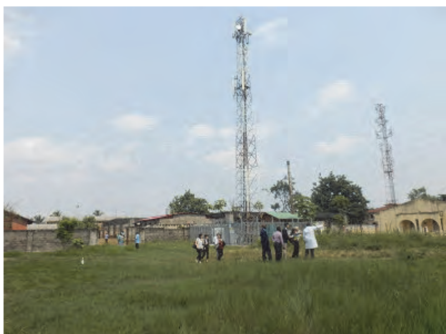
Photo 1 Terrains de construction pour le Projet. Le site est plat, mais il sera nécessaire de démanteler et de réinstaller les bâtiments existants. Aucun obstacle enseveli n'a été identifié. L'antenne visible au fond ne sera pas réinstallée.
