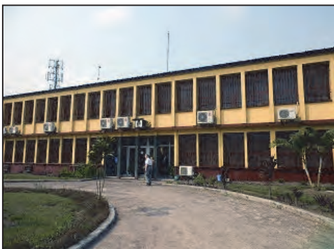
Bâtiment administratif sur le site de l'INRB
