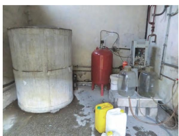
配水本管の送水圧で床置コンクリートタンク (写真左) に貯水され、そこから圧力タンク及び加圧ポンプ (写真中央) により各系統に送水される。写真手前は蒸留装置。
