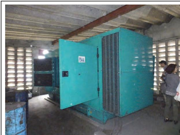
受変電室に設置されている主電源用の非常用発電機 400KVA。運転、発停操作は手動で行っている。維持管理は適切に行われており状態は良好である。
