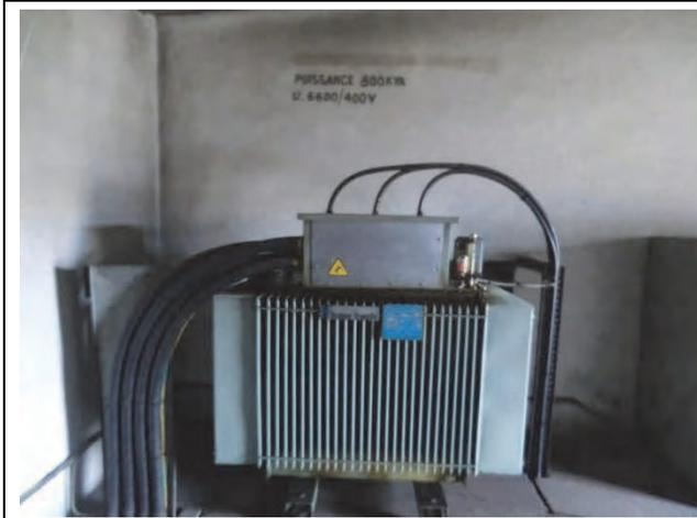
受変電室の変圧器 800KVA。引込み電圧 6,600V から 480V へ降圧している。INRB 構内のベルギーの支援により新築された保健省施設にも送電する計画である。設備は古い。
