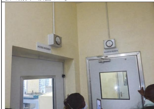
P3 検査室の前室。扉のインターロック、差圧計による室内圧の監視が確実にされている。
