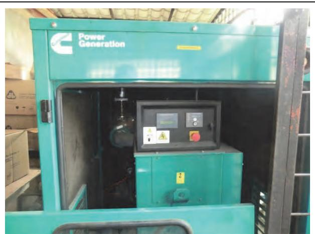
ウイルス研究棟に設置されている非常用発電機 55KVA。主電源用発電機と同様に手動運転。維持管理状態も良い。
