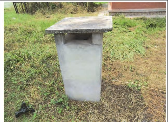
冷凍庫横にある地中埋設型の浄化槽。INRB 構内に 5 箇所に設置されている。腐敗槽、沈殿槽の 2 槽式と思われる。
