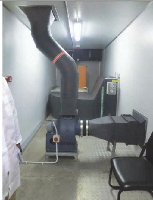
施設屋外に隣接する P3 検査室用空調機室。コンテナを利用したものでパッケージユニット、フィルタユニット、安全キャビネット用排気ファンが設置されている。この状態で南アから搬出された。
