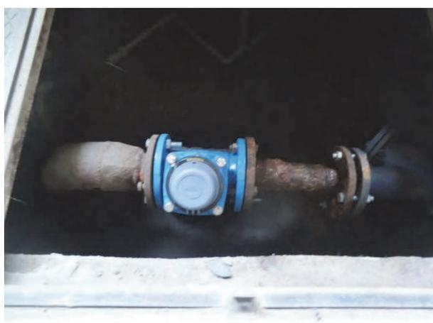
市内送水網本管からの引き込み分岐管に設置されている量水器。
