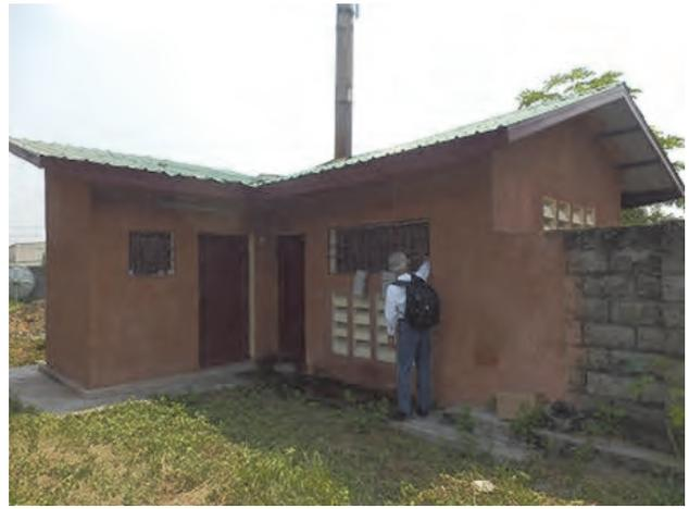
写真8 ベルギー支援により設置された既存焼却炉。処理容量が不足しているほか、十分に燃焼が出来ていない様子。
