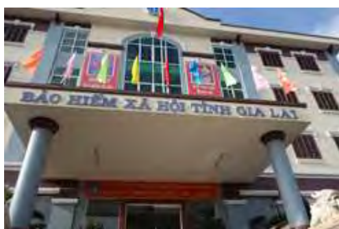
Hình 3-4 Lối vào của BHXH tỉnh
