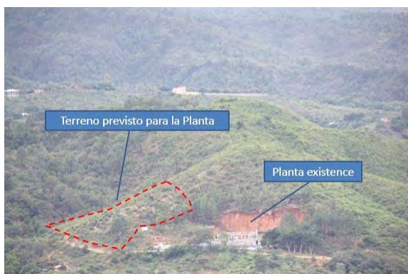
Foto-1 (vista panorámica terreno de la Planta P. prevista)
