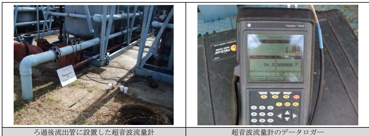
写真 4 浄水処理量の計測状況
