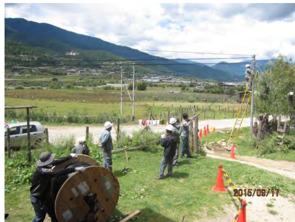
写真 1-8 第2回トライアル工事の様子(左：工事前ミーティング、右：ケーブル敷設)
