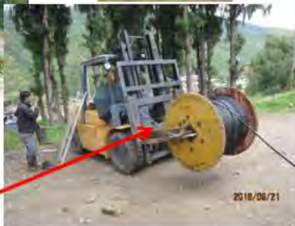
ケーブルジャッキによるケーブル架渉工事
