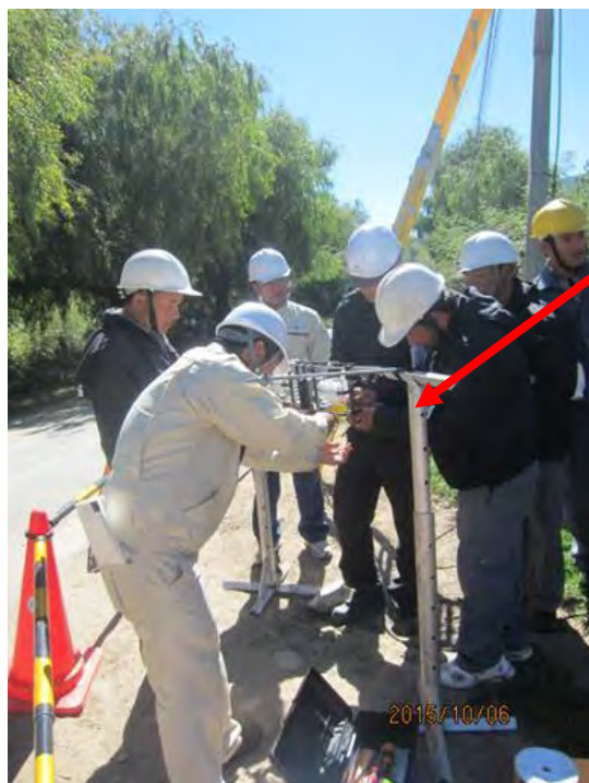
写真 1-9 光ファイバー接続用簡易作業台の製作と利用
