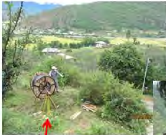
ケーブルジャッキによるケーブル架渉工事
