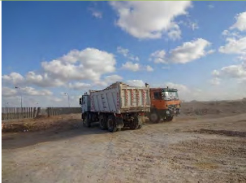
写真-1：新キャンパス建設予定地（現在造成工事中）
