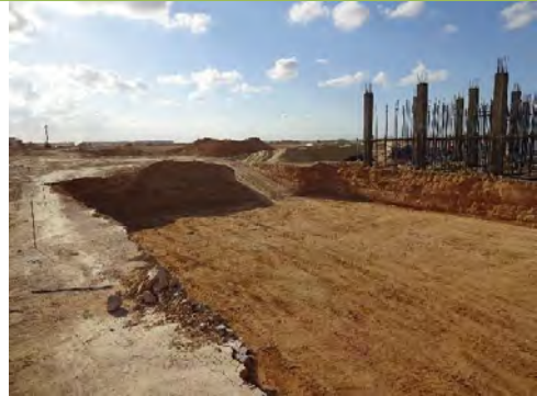
写真-2：新キャンパス建設工事（共通設備棟）
