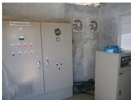
機械室内部（動力制御盤とオゾン発生装置）
