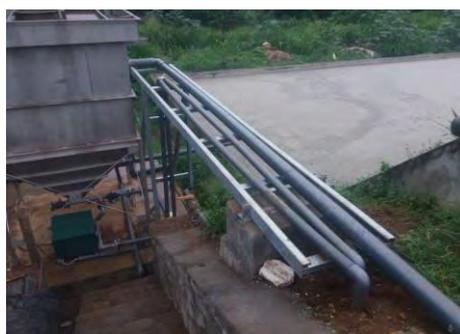
沈殿槽とアクセス階段/パイプサポート設置
