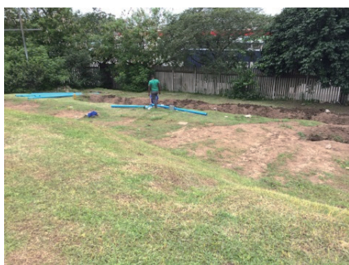
eThekwini 水・衛生局研修センター試験ヤード
