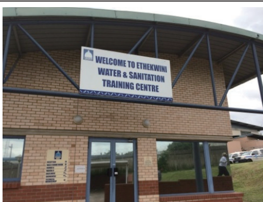
eThekwini 水・衛生局研修センター本棟
