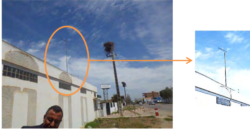
写真 2-16 配電線分岐所の通信用アンテナ
