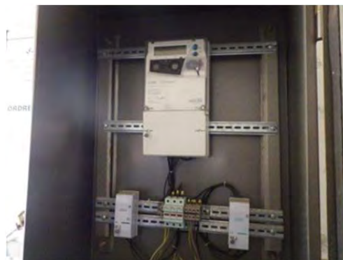
写真 2-12 MV 顧客向けデジタル計器 (Itron 製 SL7000)
