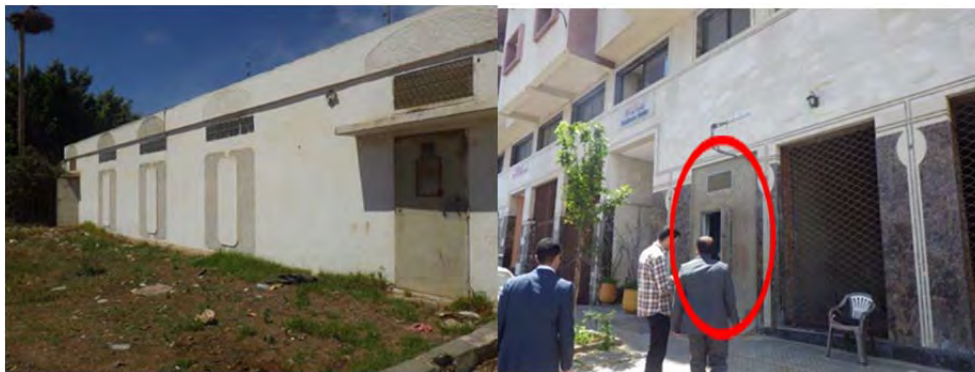
写真 2-3 配電線分岐所建物外観
