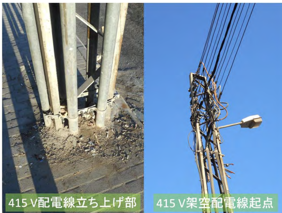
図 7.1-3 アンマン市内の 415 V 架空配電線の様子
