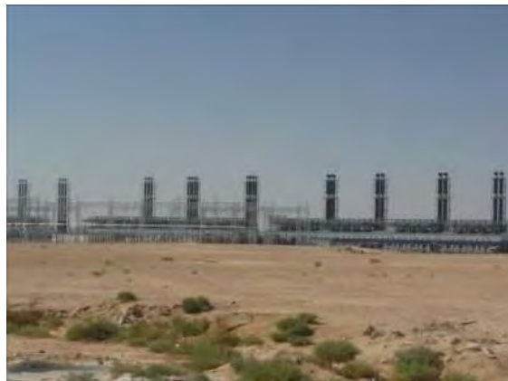
発電設備外観
