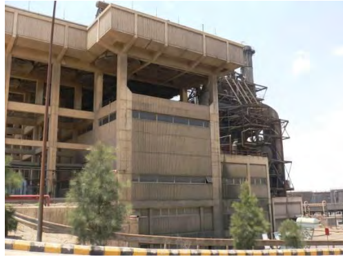
発電設備外観(Unit No.7)
