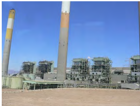
発電設備外観
