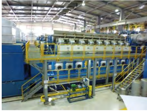
発電設備建屋
