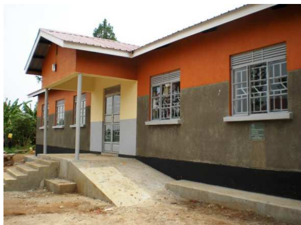
難民居住地外のKituchi HC Ⅲにリファラル強化 のためUNHCRが手術室を建設 (Kyangwali)
