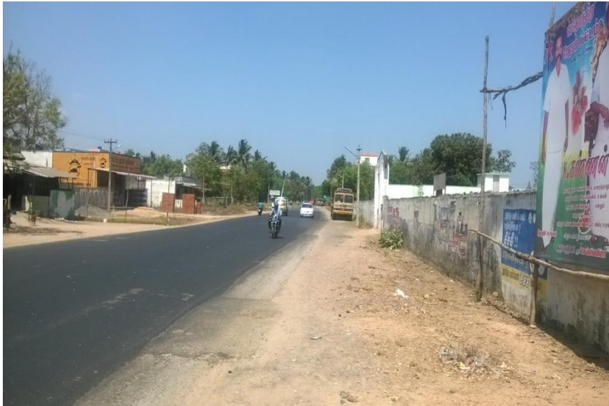
Point No: 8 on NH205 Chevvapet
