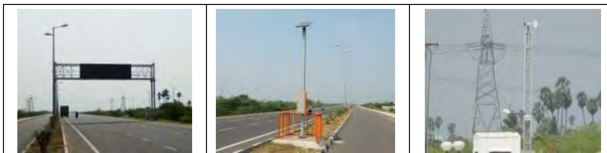
図 2. 41 情報板 (左)、非常電話 (中央)、気象観測装置 (右)
