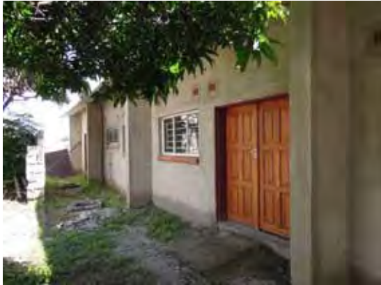
産科棟（建設中）
