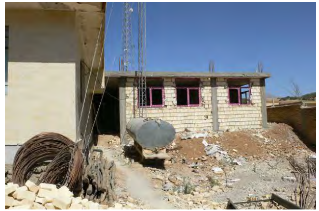
バズフトゲストハウス建設：プロジェクトは資材購入、NRWGOが建設。(2011年6月、バズフト地区テロルド町)
