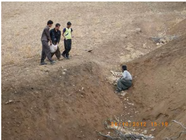
森林草地分野：チェックダム維持。洗掘された水たたき部分の補強工事。(2012年10月、バゾフト地区マゼラシュテ村)
