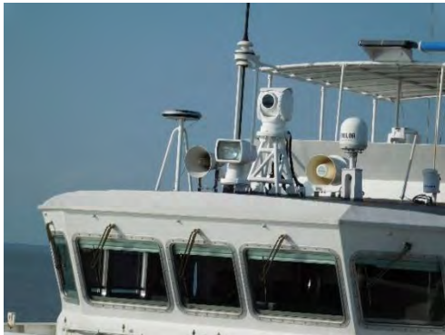
写真 8 設置工事 カメラ部設置完了 2015年12月撮影
