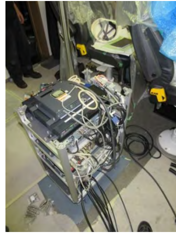
写真 7 設置工事 操作部設置 2015年12月撮影
