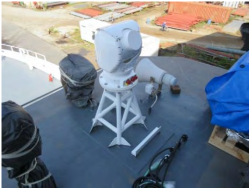
写真 6 設置工事 カメラ部設置 2015年12月撮影
