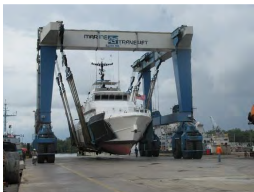
写真 4 設置工事 上架作業
