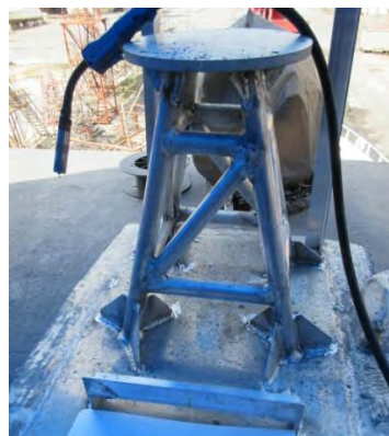
写真 5 設置工事 架台溶接終了時
