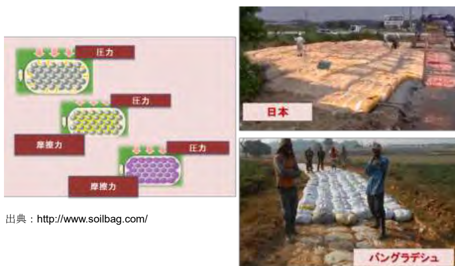
図 5.5.1 土嚢道路建設技術コンセプト及び適用例
