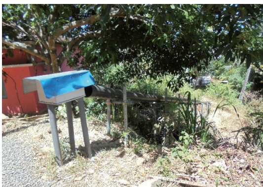
ヌワラエリア県のパイロット地区に設置されている観測機材
