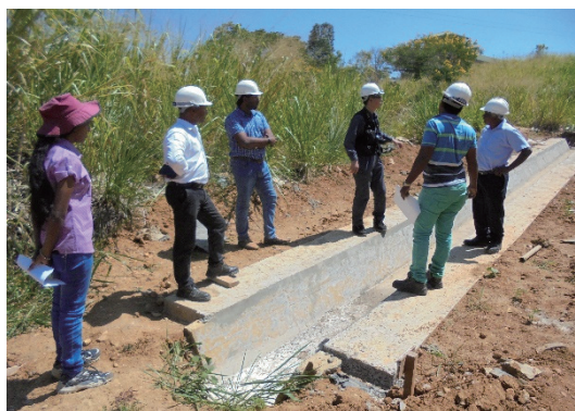
バドゥツラ県の施工現場（地すべり対策工）
