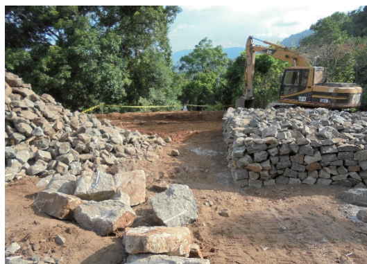
マタレ県の施工現場（落石対策工）
