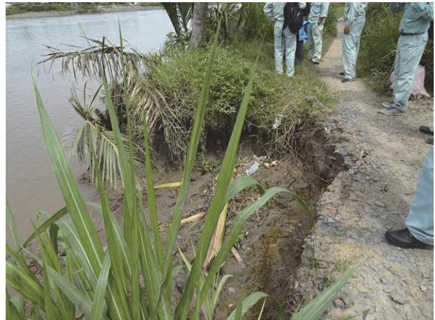
写真 3-1 洗掘が見られるチョーガ才運河護岸
