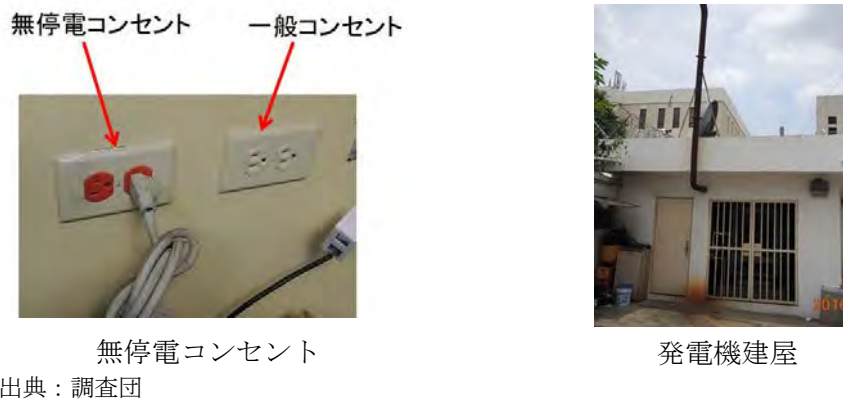
写真 2-1-3 ODPEM 本部内の無停電コンセント及び発電機建屋
