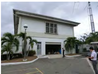
ODPEM 本部倉庫（キングストン）
