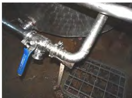
写真 5-9 アーク溶接による配管
