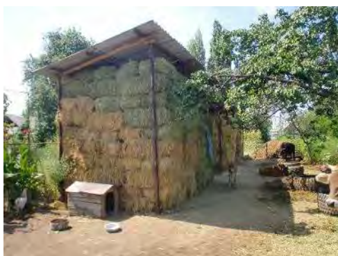
写真 3-7 キルギスの典型的な飼料保管庫 事例 1
