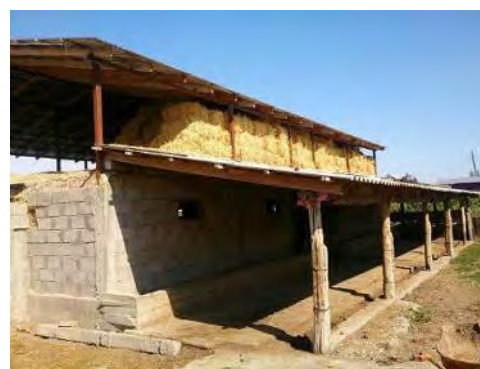
写真 3-8 キルギスの典型的な飼料保管庫 事例 2
