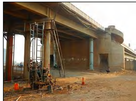
写真 2-2-9 P8 橋脚（陸上）ボーリング
