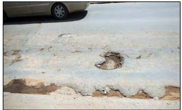
写真 - 6 : 劣化・損傷の著しい橋面舗装 (交通量の多さと暑熱により劣化・損傷が著しい)
