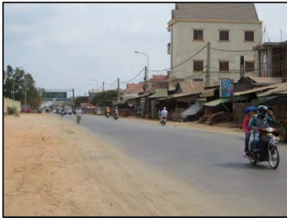
写真 2-2-1 国道5号線の整備状況
