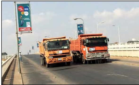
写真 - 11 : ダンプトラック 2 台による載荷試験 (載荷試験により PC 橋部のたわみを計測)
