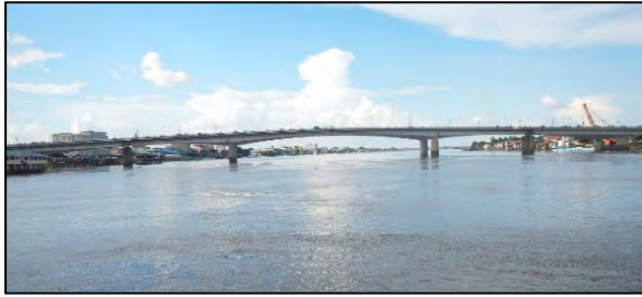
写真 - 1 : チュルイ・チョンバー橋全景 (側面) (5 径間 PC 橋+2 径間鋼橋+3 径間鋼橋+2 径間鋼橋+5 径間 PC 橋)
