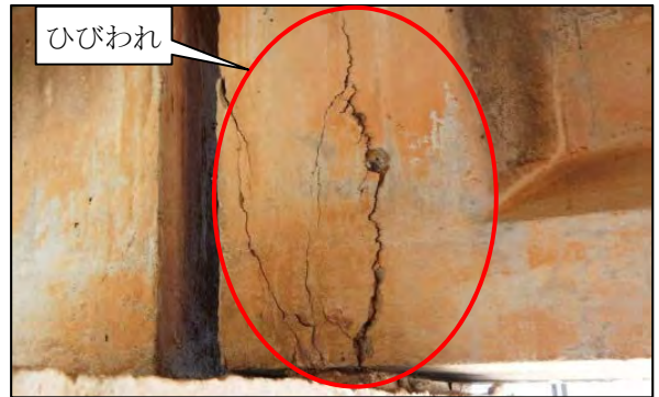
写真 - 4 : 主桁端部の著しいひびわれ (ひびわれにより主桁耐荷力の低減が懸念される)
