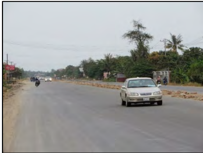
写真 2-2-3 拡幅工事中（2015 年 2 月）
