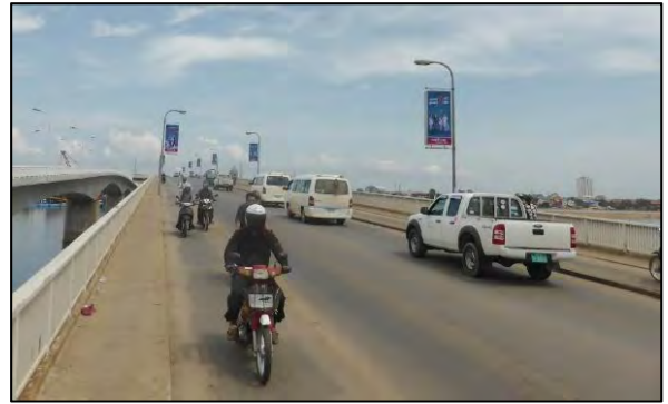
写真 - 2 : チュルイ・チョンバー橋全景 (正面) (車線 3.5m×.+バイク 1.9m イ・+歩道 1.1m イ・=13.0m)
