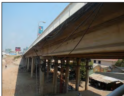
PC橋に添架されている通信線（光ファイバー等）
