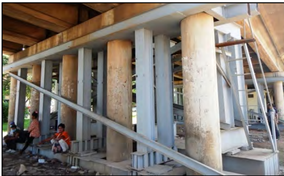
写真 - 5 : 上部工補強用支柱 (落橋寸前の上部工を支えている補強用の支柱)
