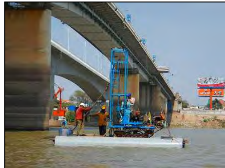
写真 2-2-7 P3 橋脚（河川内）ボーリング
