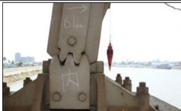
写真 - 16 : 支承の傾斜測定 (さげ振りによる鋼橋部橋脚の支承の傾斜測定)
