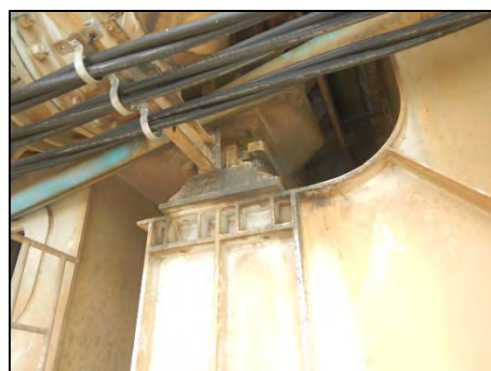
鋼箱桁に添架されている高圧線（22kv 3条）
