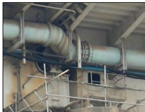
鋼箱桁に添架されている水道管（φ800mm）
