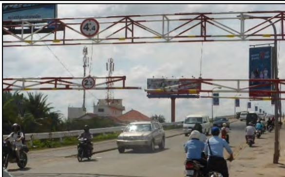
写真 - 7 : 大型車用規制ゲート (耐荷力不足のため大型車の侵入を規制するゲート)
