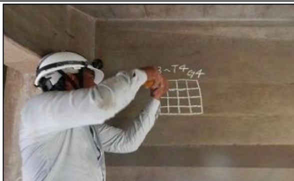
写真 - 15 : 反発硬度試験 (シュミットハンマーによるコンクリートの硬度測)
