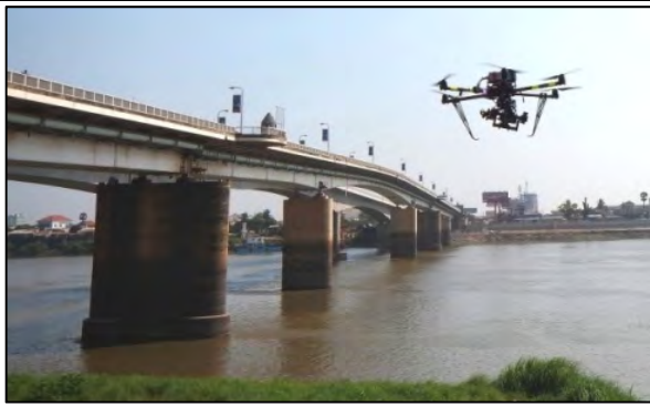
写真 - 9 : ドローンによる橋梁外観調査 (足場が設置できない箇所でのドローンを活用)
