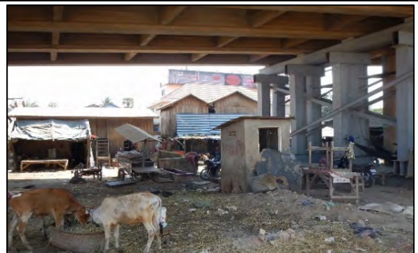
写真 - 8 : 住民移転対象家屋 (住民移転及び撤去が必要となる家屋)
