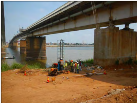
写真 2-2-6 P2 橋脚（陸上）ボーリング
