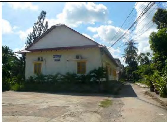
耳鼻咽喉科棟 1962年寄付により建設、2014年改修
