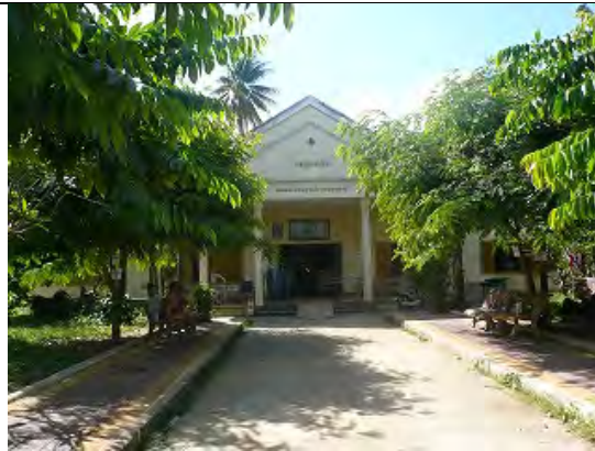
内科 ICU 棟 1988年建設
