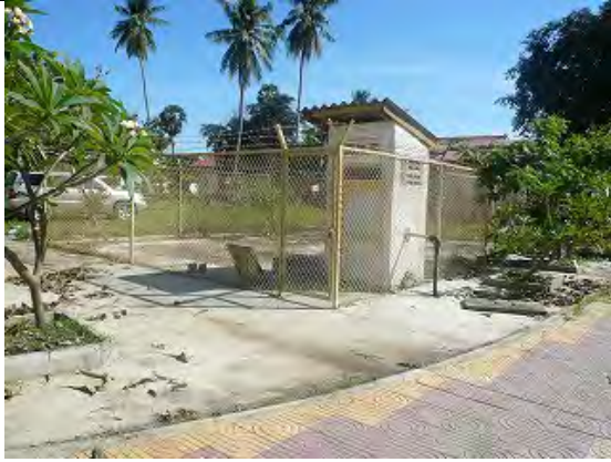
受水槽 市水道から水を引込む
