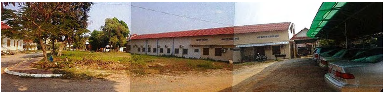
建設予定地 外来・救急棟北側の北西側から撮影
