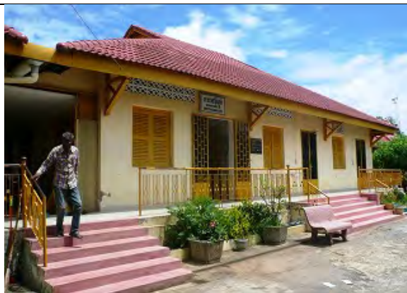
眼科棟 建設時期不明、2010年 AusAID により改修
