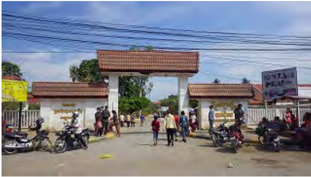
病院正面ゲート
