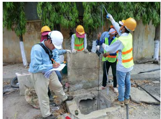
写真 R 2.2.2 マンホール調査実施状況
