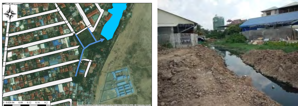
図 R 3.2.9 トルコク 2 排水機場湿地周辺の状況 (左図：確認された水路のルート、右図：開水路の状況)
