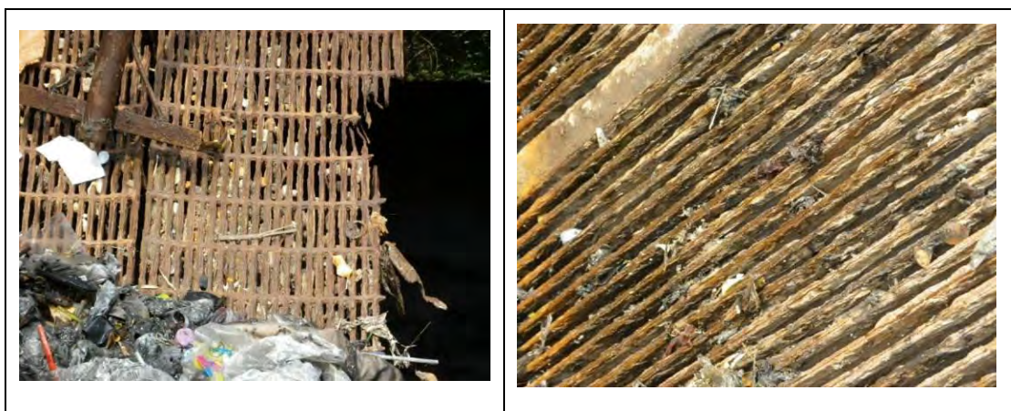
写真 R 3.2.2 既設バースクリーンの状態
