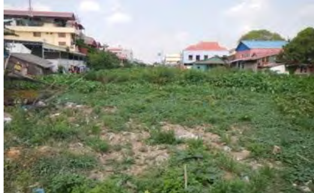
排水管路の排水先、トルコーク 1 排水機場手前の湿地
