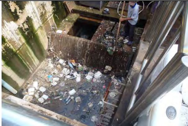
フェーズ 2 で建設したポンプ場のスクリーンピットで人力によるゴミの除去作業を行っている
