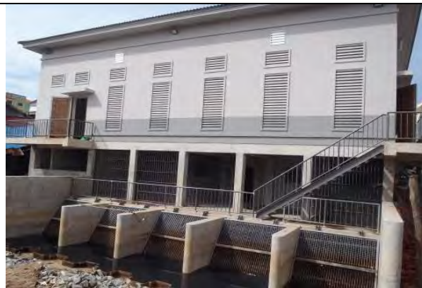
新トルコーク II 排水機場（プノンペン都が建設中）
