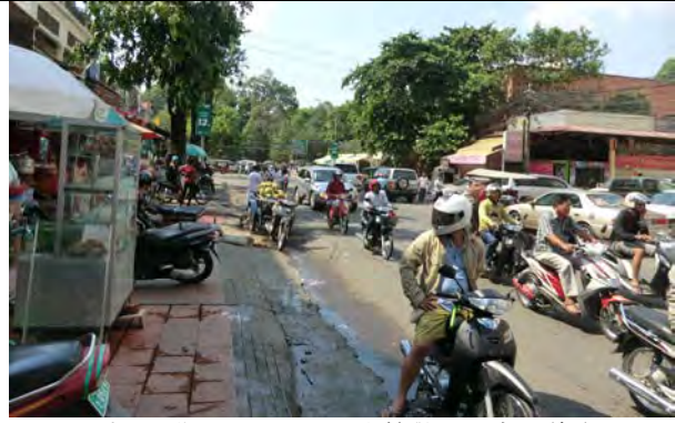
ワットポン北側エリアの配水管敷設予定の道路
