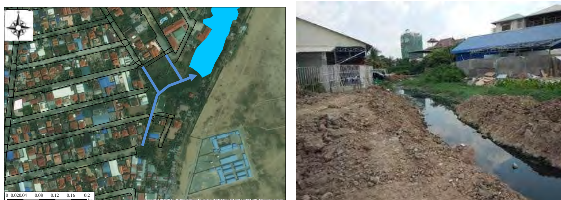
図 R 3.2.9 トルコーク2排水機場湿地周辺の状況 (左図：確認された水路のルート、右図：開水路の状況)
