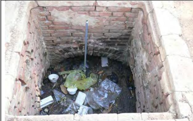
堆積物により排水管路の流れが阻害されている状況
