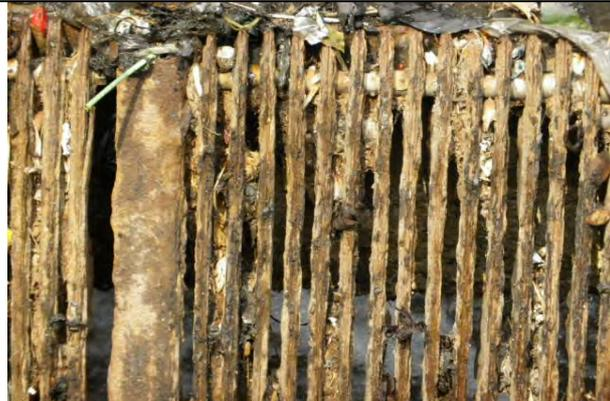
スクリーンピットにおける、著しく腐食の進んだ鉄製のバースクリーン (拡大)
