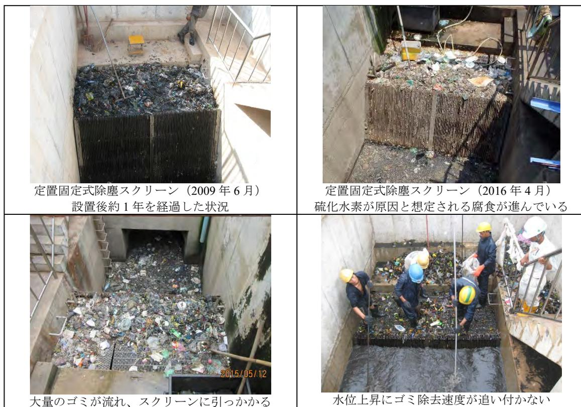
写真 R 2.1.2 フェーズ 2 で整備した排水ポンプ場の除塵スクリーンの現状
