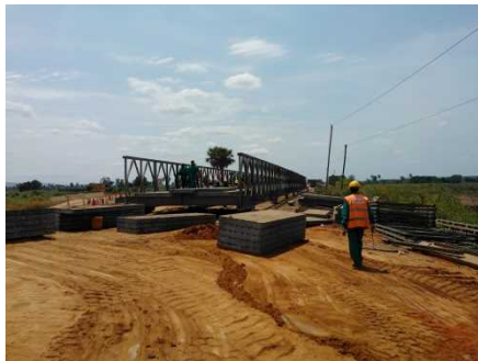
ベイリー橋建設 (1)
