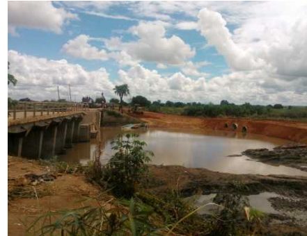
写真 2-2-14 メサロ橋Ⅲ付近での仮設バイパス道路建設
