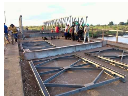
写真 2-2-13 メサロ橋Ⅰ上でのベイリー橋建設
