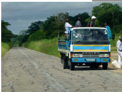
(R698 の舗装状況)
