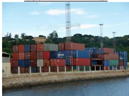
コンテナヤード
