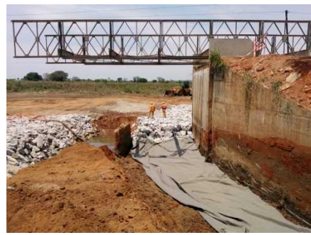
ベイリー橋建設 (2)
