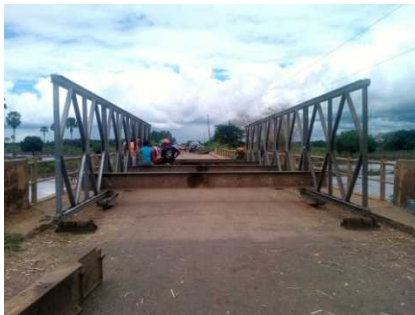
写真 2-2-13 メサロ橋Ⅰ上でのベイリー橋建設
