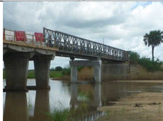
ベリリー橋区間
