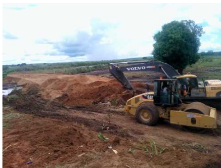
写真 2-2-14 メサロ橋Ⅲ付近での仮設バイパス道路建設
