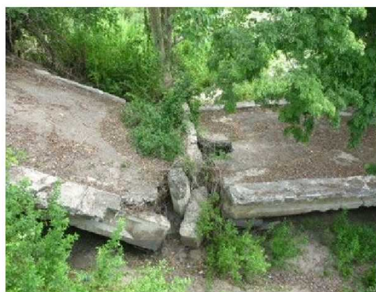
下流側の既設橋
