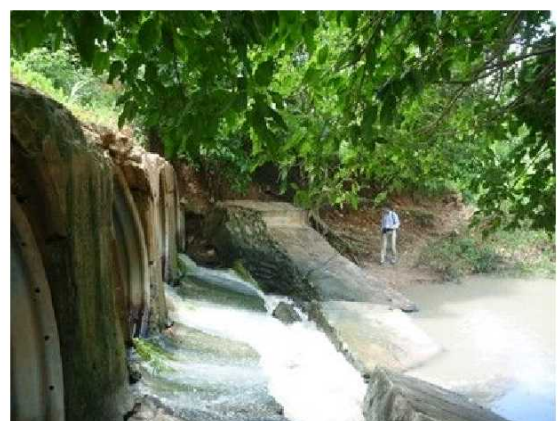
下流側のアウトレット部での河床変動
