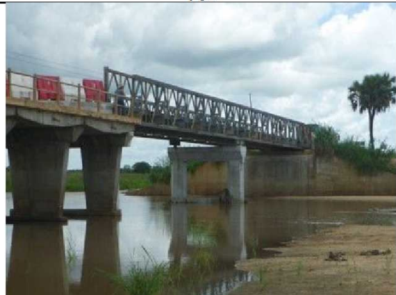
ベリリー橋区間
