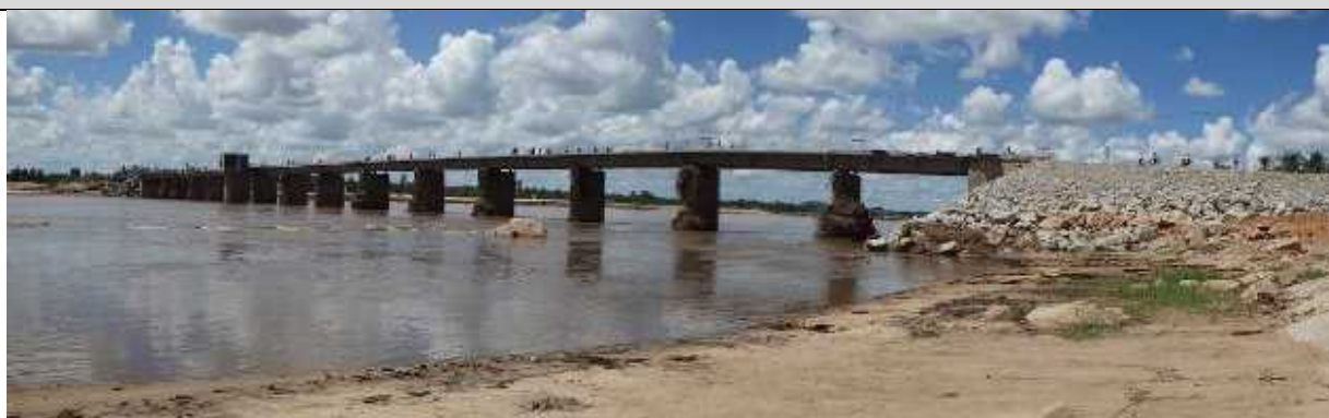
橋梁全景：撮影時は雨季後半であったが河川流量は比較的少ない。
