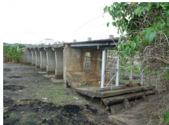
写真-6 ムエラⅠ橋 一部橋梁が落橋し、H型鋼の仮設橋により修復された。
