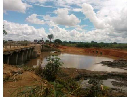
写真 2-2-14 メサロ橋 III 付近での仮設バイパス道路建設
