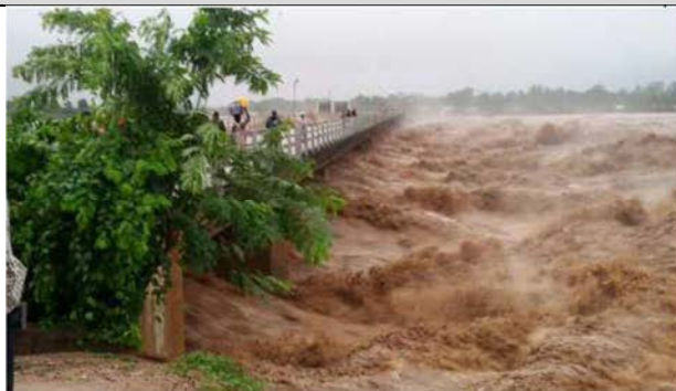
洪水時のリクンゴ川の様子（A1橋台側より）
