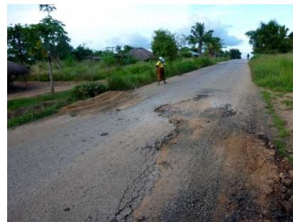
(N380 の舗装状況)
