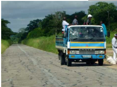
(R698 の舗装状況)
