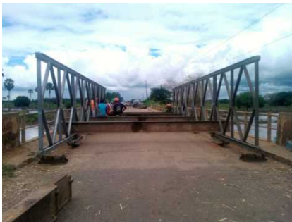
写真 2-2-13 メサロ橋 I 上でのベイリー橋建設
