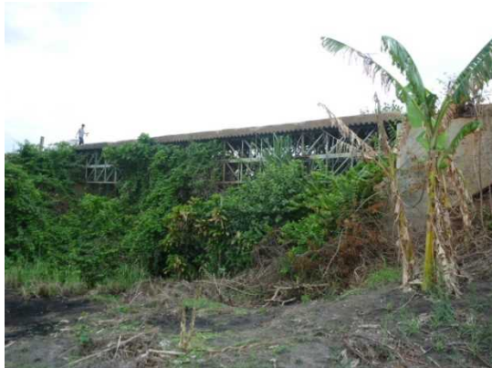
写真-7 ムエラⅡ橋 ベイリー橋と同じ鋼トラス桁タイプの仮設橋により交通を解放している。
