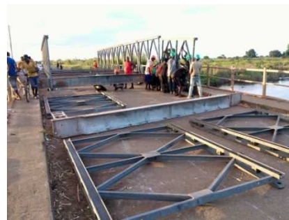
写真 2-2-13 メサロ橋 I 上でのベイリー橋建設
