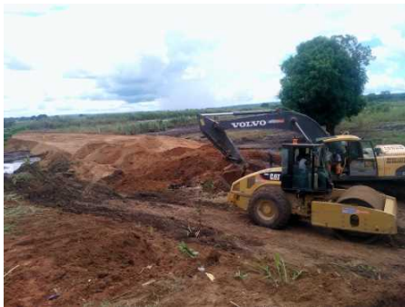
写真 2-2-14 メサロ橋 III 付近での仮設バイパス道路建設
