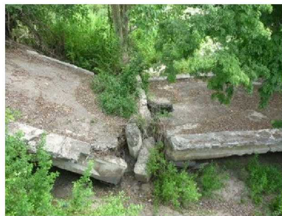
下流側の既設橋
