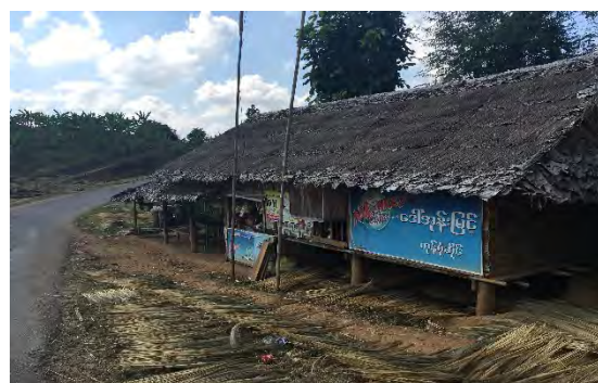
道路用地内にある店舗 (Lay Eain Su, Taungoo)
