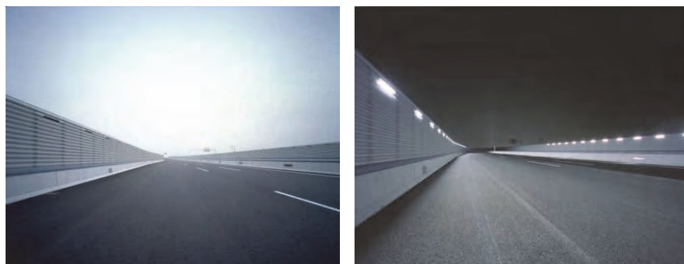
図 4-5 遮音壁付き高欄 LED ライト
