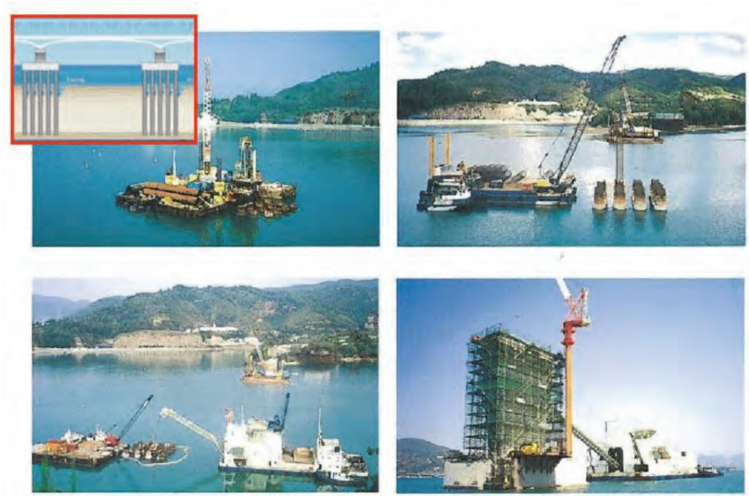
図 12.4.6 橋脚掘削地点の濁水対策（Bored Pilling Method）
