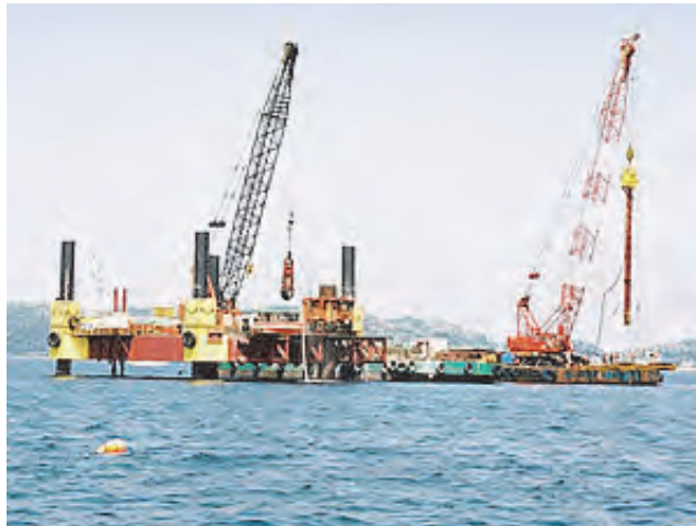
図 7.2.3 海上部場所打ち杭の施工例
