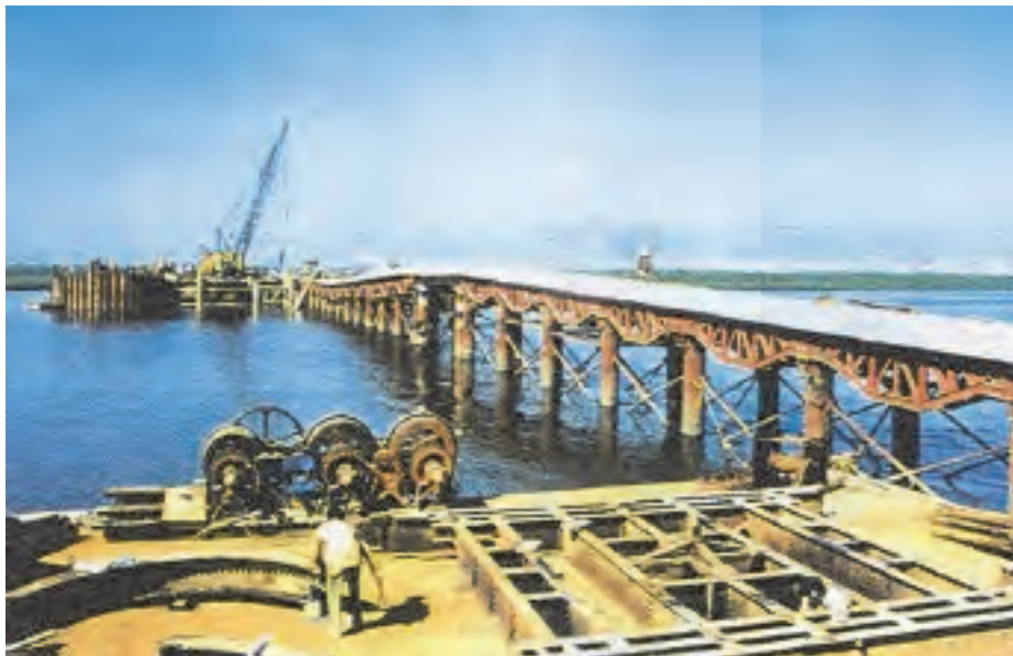
図 12.4.7 仮設栈橋による工事の実施
