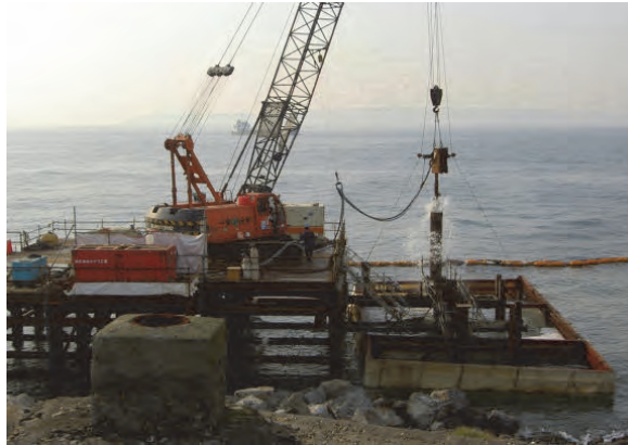
図 7.2.2 栈橋部場所打ち杭の施工例
