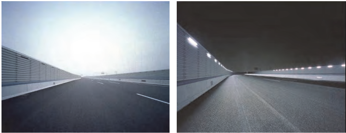
図 12.4.8 遮音壁付き高欄 LED ライト
