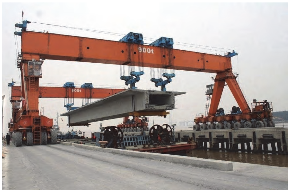
図 7.2.17 門型クレーンによる一括架設工法（陸上部）
