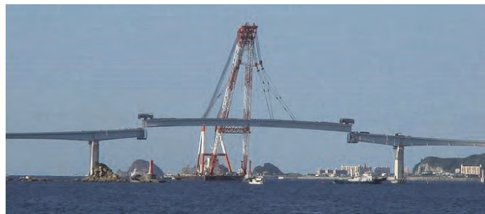
図 7.2.15 フローティングクレーンによる一括架設
