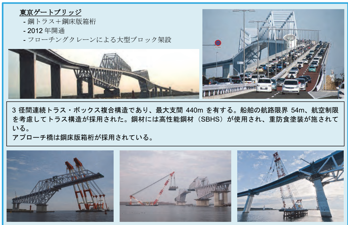
図 6.5.13 日本の海上鋼橋梁例 4 (東京ゲートブリッジ)
