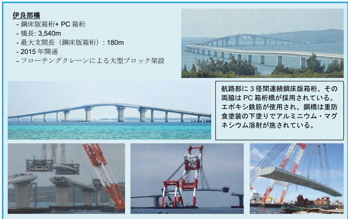
図 6.5.14 日本の海上鋼橋梁例 5 (伊良部大橋)
