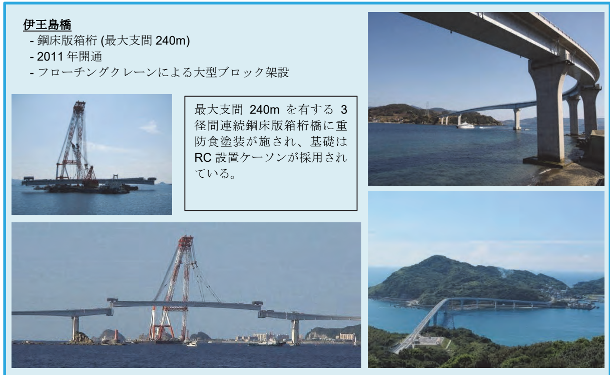
図 6.5.12 日本の海上鋼橋梁例 3 (伊王島橋)
