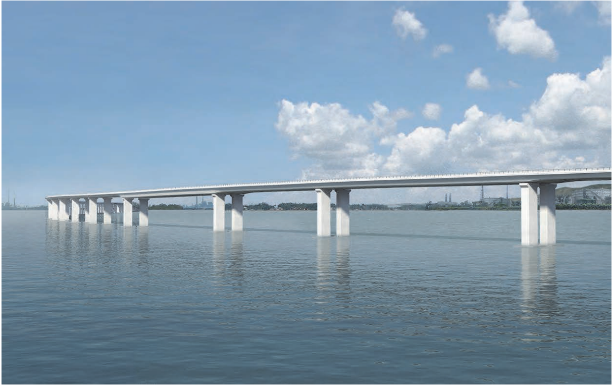
完成予想図：鋼床版箱桁橋区間
