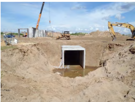
開発地にて埋設中のボックスカルバート
