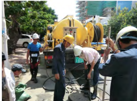
DSDによる管渠清掃の状況
