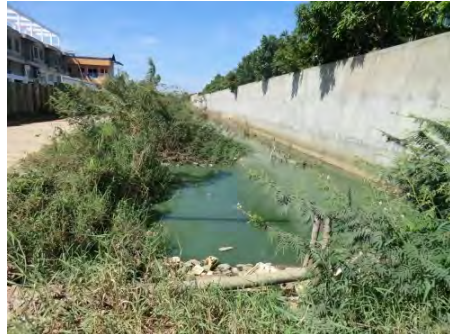
既設排水路の状況(2/2)
