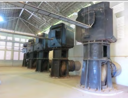
既設ポンプ場(Kop Srov ポンプ場)
