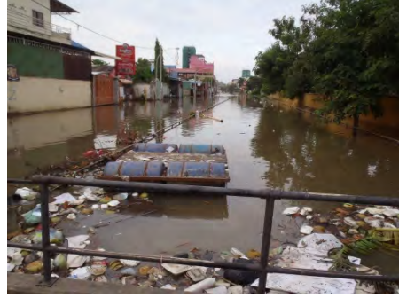
浸水の状況(Trabek 排水路)
