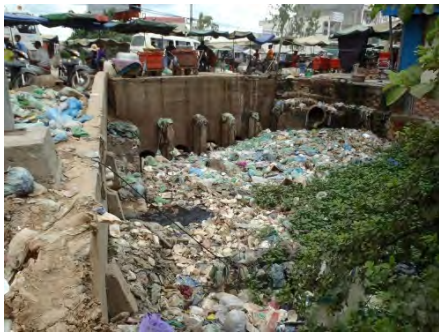
既設排水路の状況(1/2)
