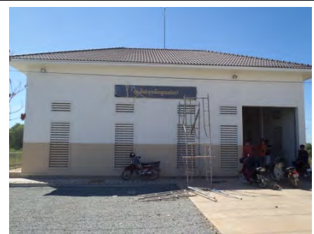
既設ポンプ場(Tuol Sampeo ポンプ場)
