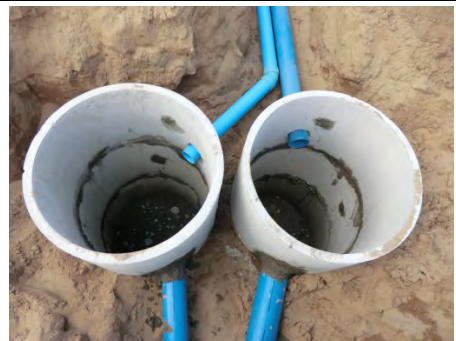
建築中家屋の腐敗槽
