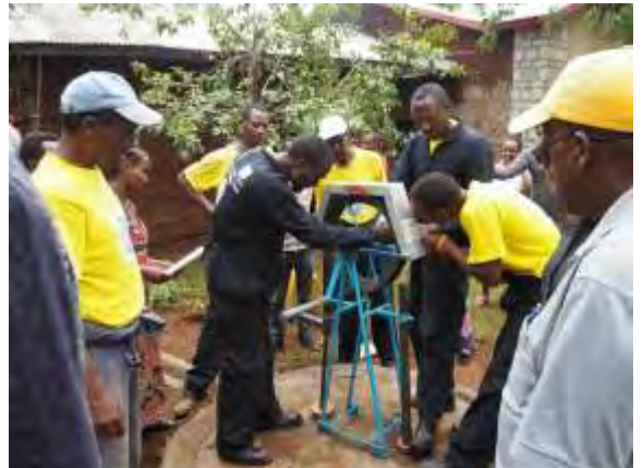
ከተከላ በኋላ የገመድ ፓምፕ ምርመራ ሲካሄድ (ፎቶ በዋስ ሮፕስ)
